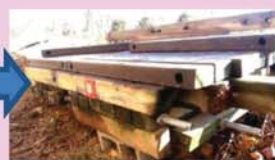
＜取り外した廃材＞
